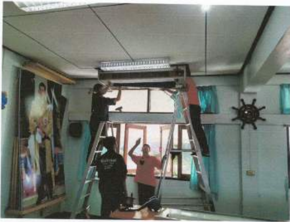
ล้างเครื่องปรับอากาศ ที่ว่าการอำเภอสอยดาว
